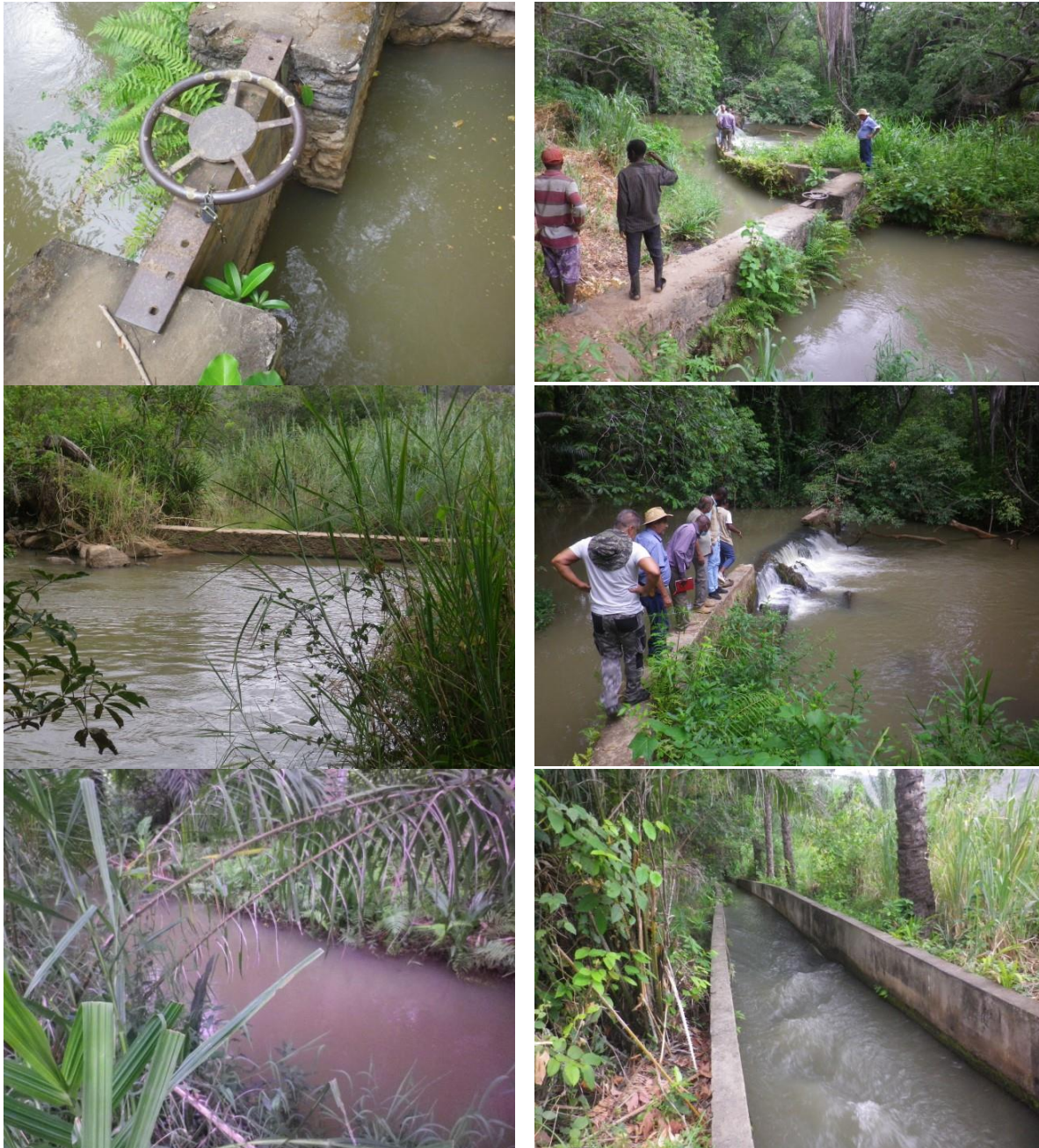
Figura 4 – Infraestruturas existentes na área do PI do Cauá (açude descarregador, canal de secção reduzida, aqueduto)
