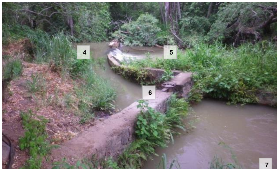
Figura 12– Enquadramento das obras da captação do Cauá - Jusante
