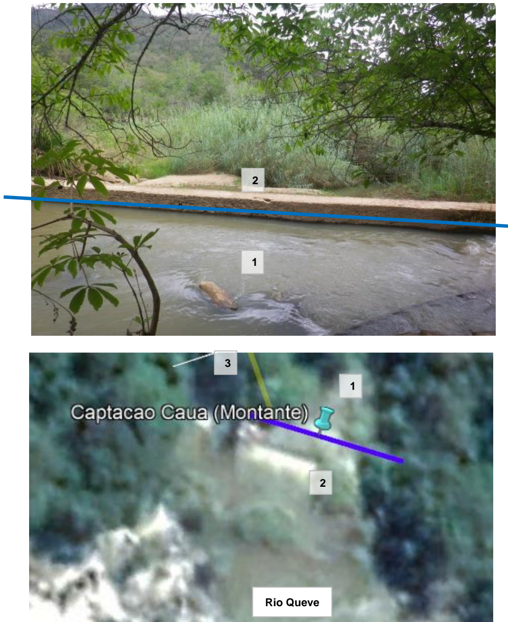
Figura 10– Enquadramento das obras da captação do Cauá - montante
