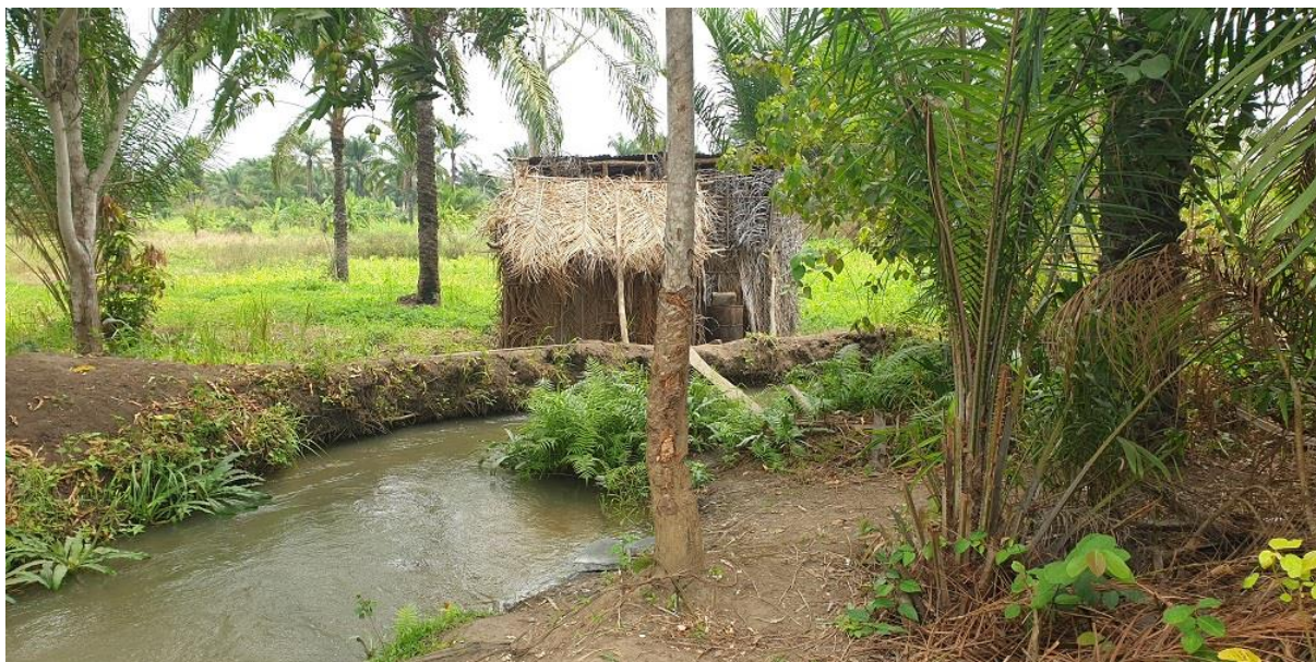
Figura 46 – Construção provisória localizada a menos de 5m do canal principal a cerca de 3,6 km a jusante da comporta de captação
