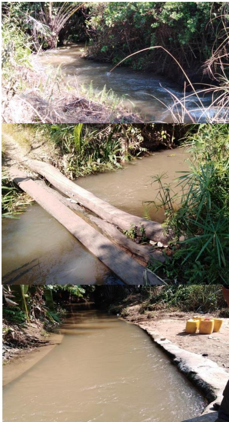
Figura 5 – Situação do canal principal do Cauá
