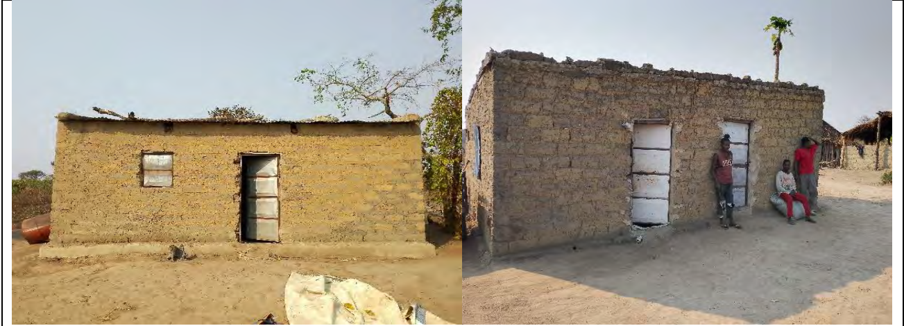
Figura 3: Residência dos Trabalhadores
