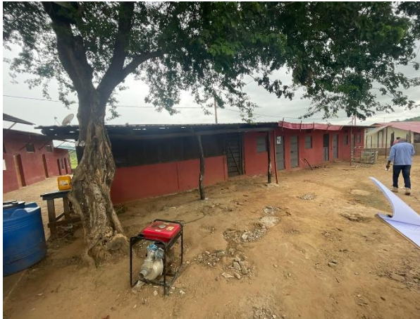
Foto 3: Local de alojamento dos trabalhadores
