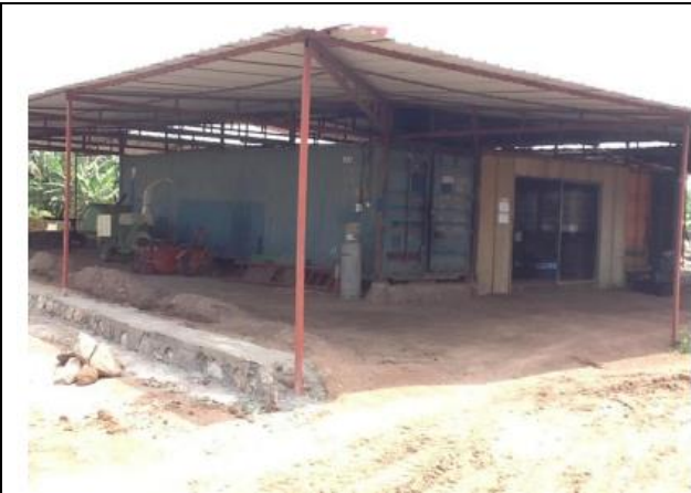
Foto 1: Armazém dos produtos
