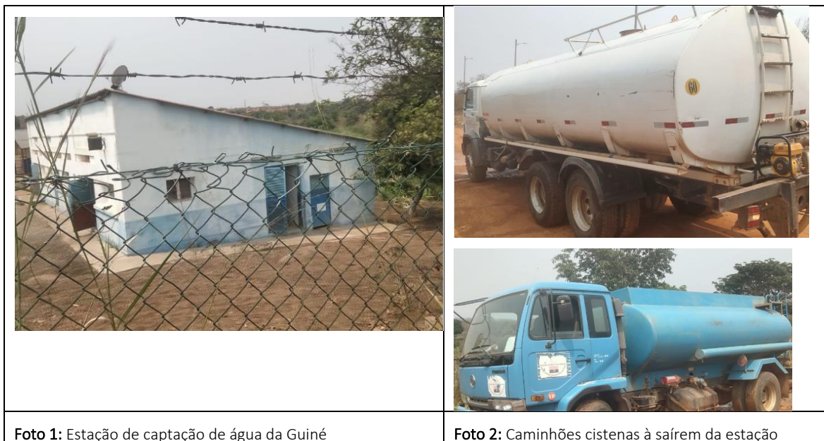
Figura 4 Registro fotográfico da Estação de Captação de Água
