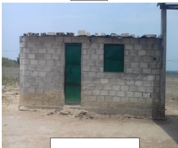
Casa dos Funcionários
