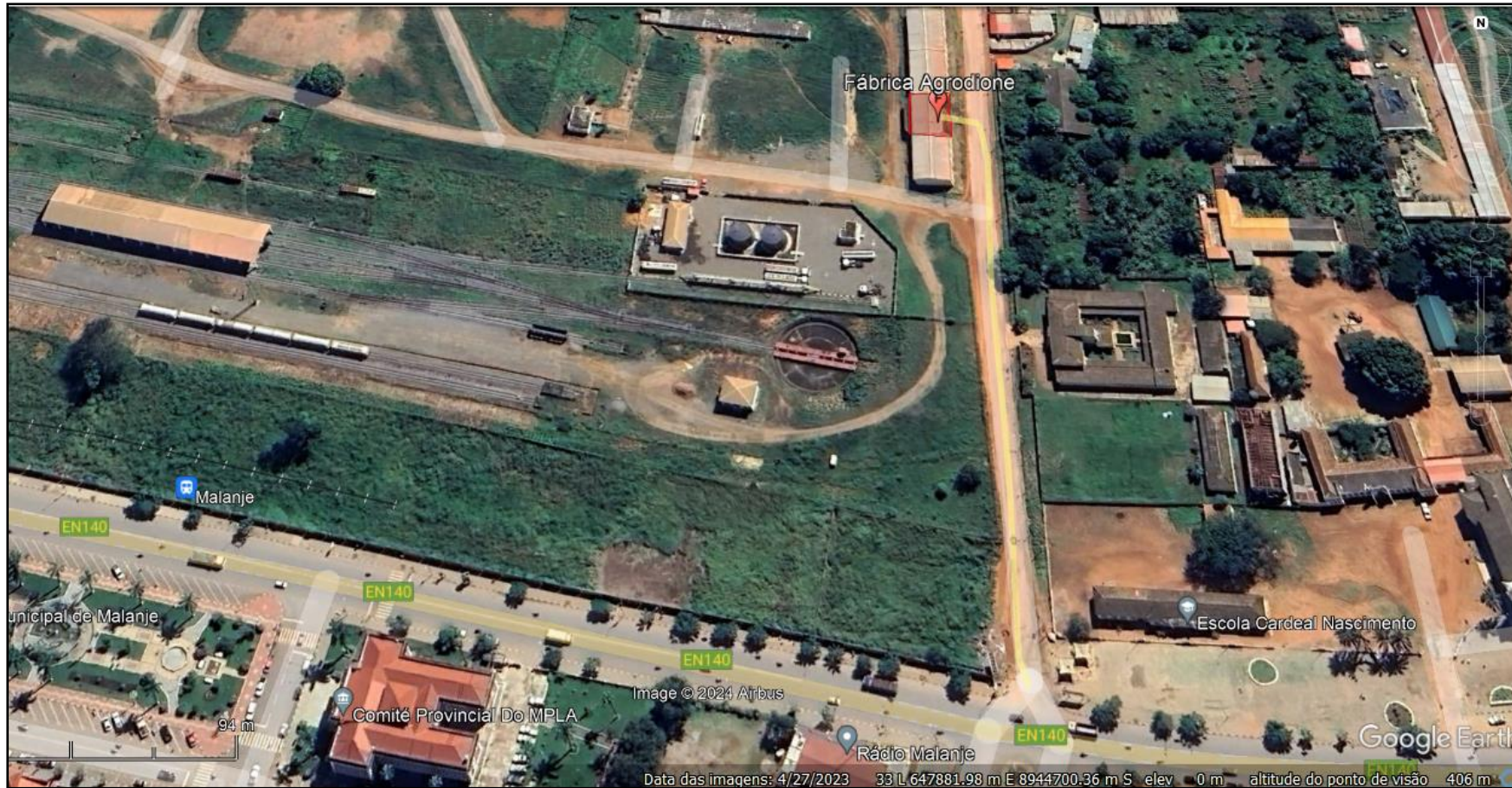
Figura 2 Área da fábrica
