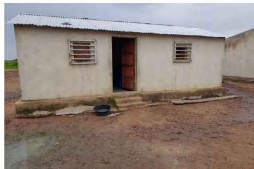
Foto 2: Casa dos trabalhadores
