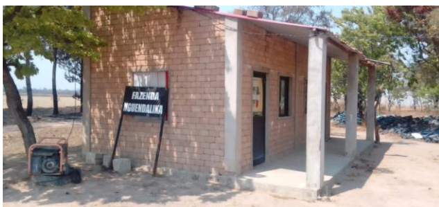
Figura 8: Residência dos trabalhadores
