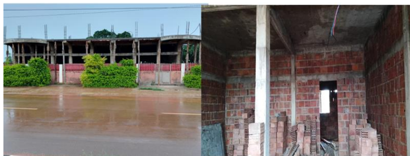
Figura 3: Armazém/loja em construção
