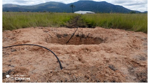
Figura 4: Furo para captação e condução de água para os pavilhões
