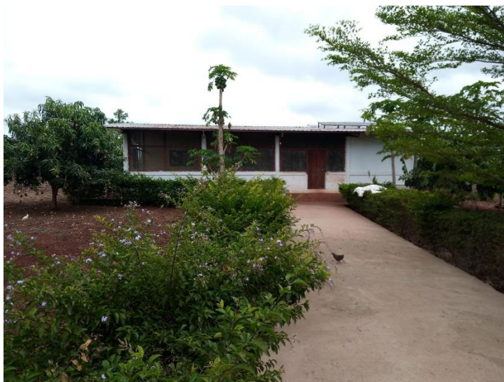
Residência e escritório
