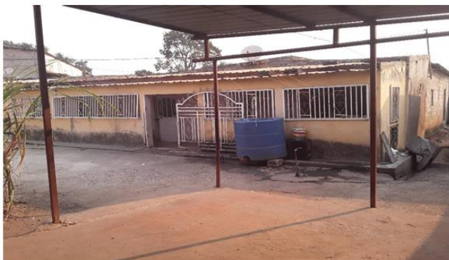
Figura 2: Vista frontal dos escritórios
