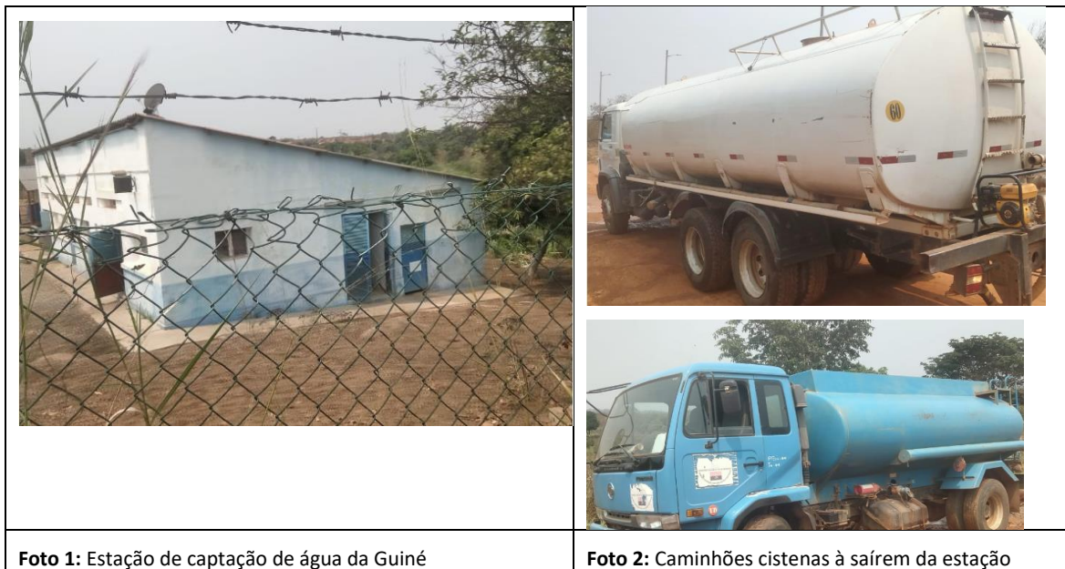
Figura 5 Registo fotográfico da Estação de Captação de Água
