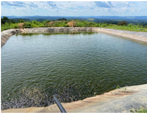
Foto 1: Bacia de retenção de água 168 m 3
