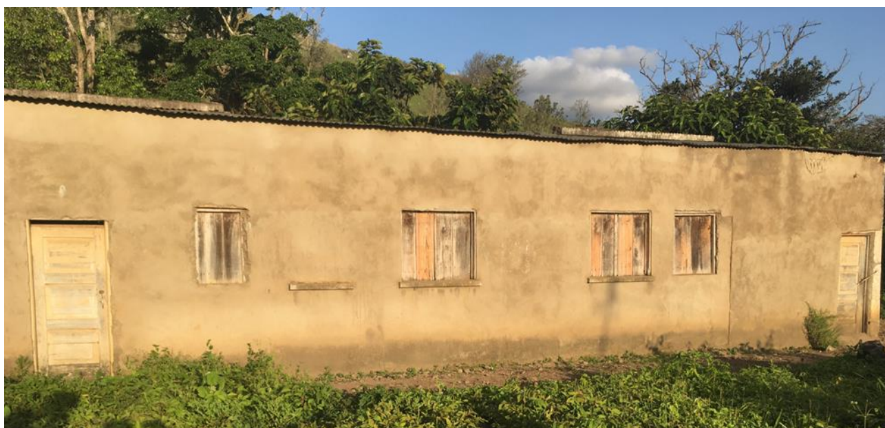
Armazém já reconstruído para o armazenamento da matéria-prima
