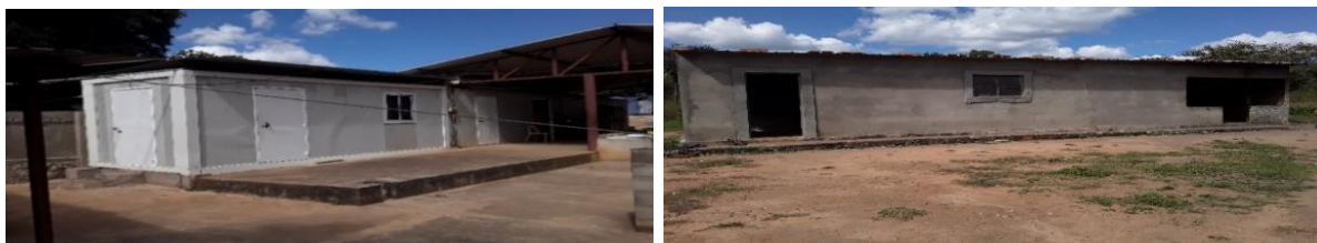
Figura 9: Alojamento Contentorizado residência construída com betão
