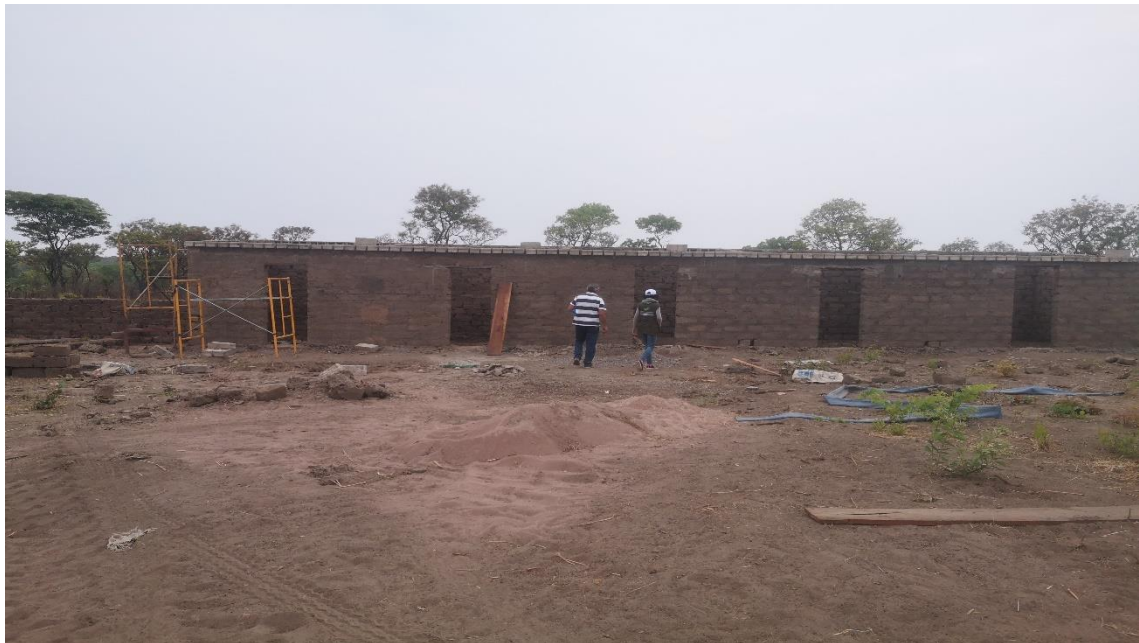
Figura 21: Futuras residências em construção
