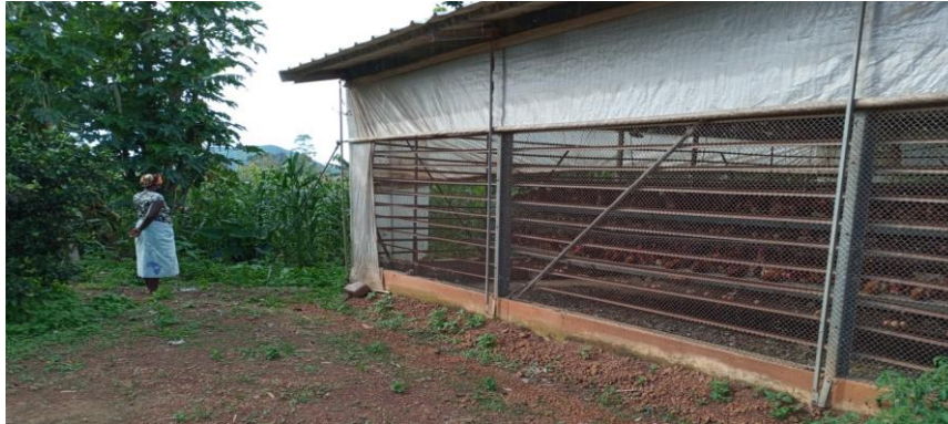
Figura 13: Pormenor do pavilhão da fazenda JOÃO QUITEQUE
