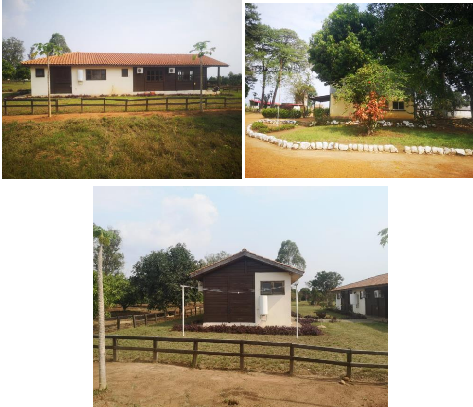
Figura 11: Residências para os trabalhadores efectivos
