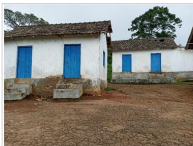
Residência dos trabalhadores
