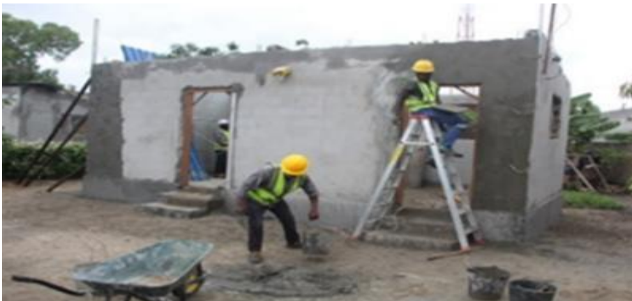
Figura 3: Residência em Obras
