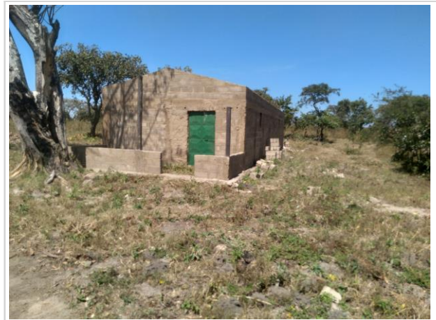
Armazém em construção
