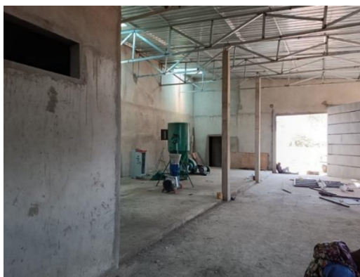
Figura 6: Infraestrutura por concluir
