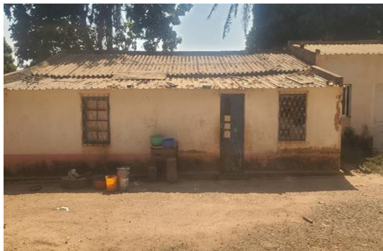
Figura 5 Casa de funcionários
