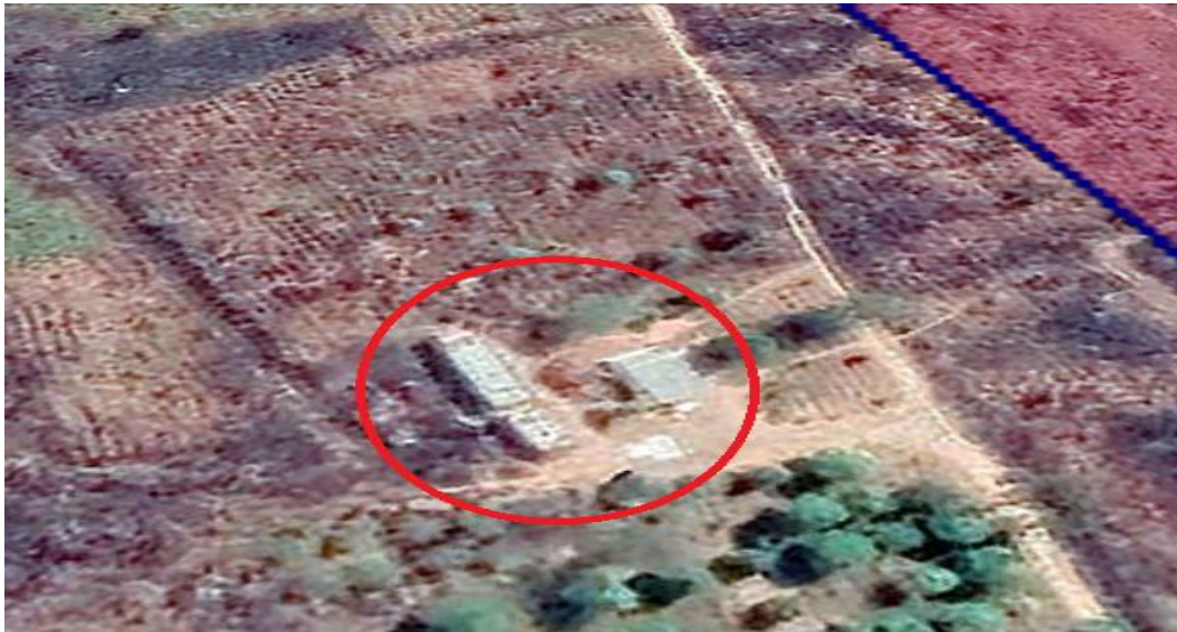
Figura 4: Área com as instalações
