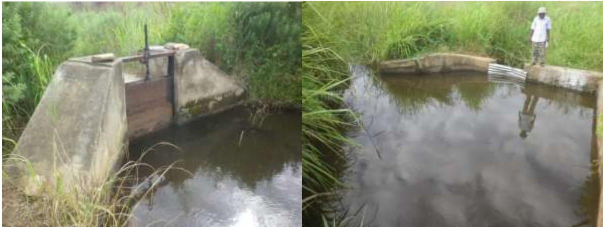
Figura 2 – Comporta e bacia de distribuição existentes
