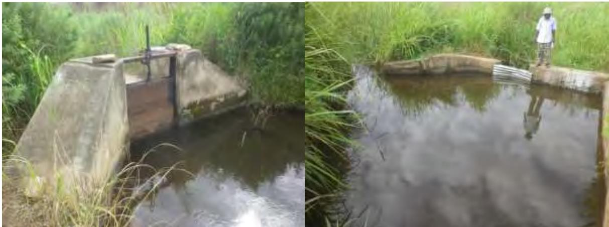
**Figura 4 – Comporta e bacia de distribuição existentes no Perímetro de Cacala**
