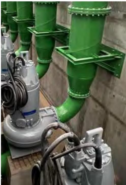
**Figura 13 – Fotografias de instalação com grupos electrobomba submersíveis, tipo drenagem**
